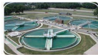
تصفیه خانه های آب
